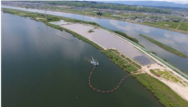
（現場写真：浚渫工）
